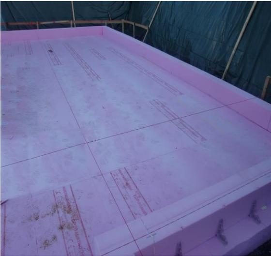
Das Iso-Therm-Bodenplattensystem ist ein Schalungssystem zum Erstellen wärmegeprägter Gründungsplatten.
